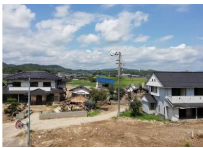
写真：被災された堤防沿いの家々窓も扉もない状態の家が並ぶ
