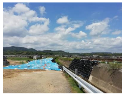
写真：決壊した堤防の修復場所 金属の杭やブルーシートが
