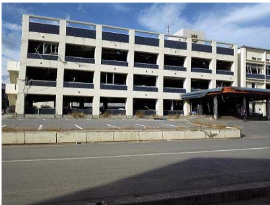
陸前高田市役所外観。屋上まで津波が押し寄せたそうです。
