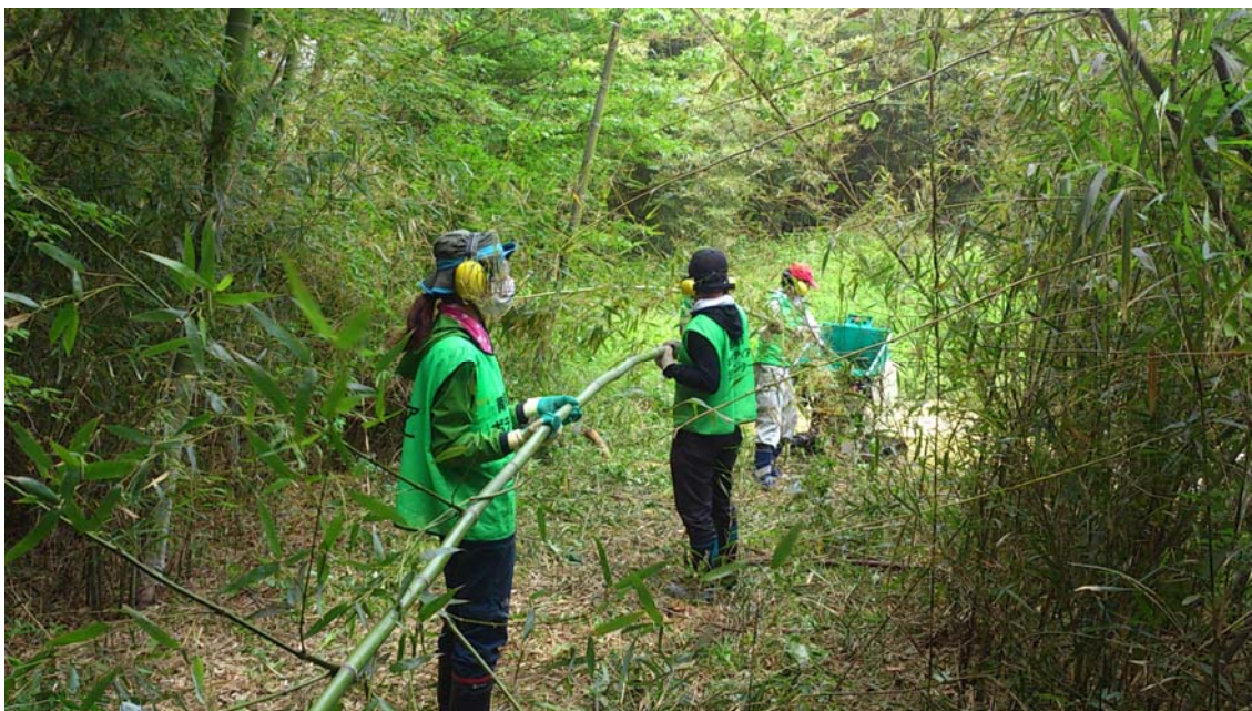
「竹やぶの伐採」 伐採した竹は、ウッドチップパーで粉碎する
