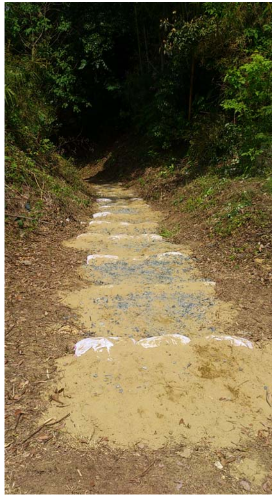
(作業後) 高齢の方でも歩きやすいように土嚢で 階段を作る
