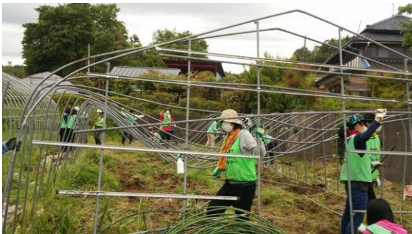
(写真：骨組みの解体作業中)
